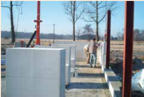
Die ersten Steine der Fitnesshalle sind platziert.
