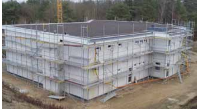
Grasdach-Vorbereitung auf vollen Touren
